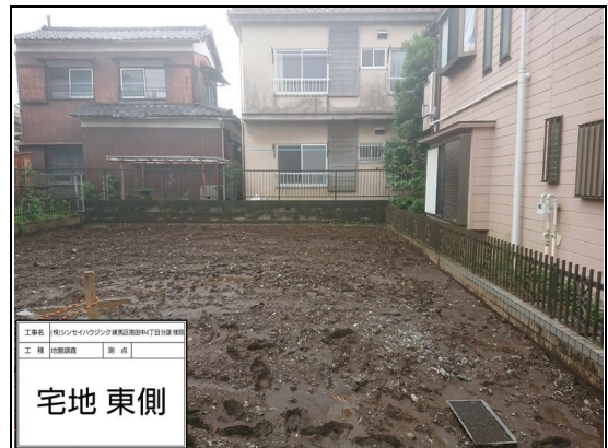
周辺状況 (宅地東側)
