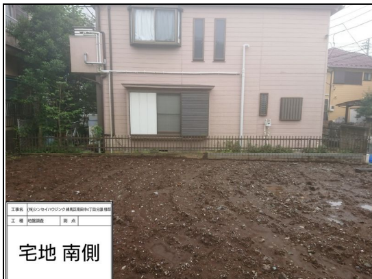
周辺状況 (宅地南側)
