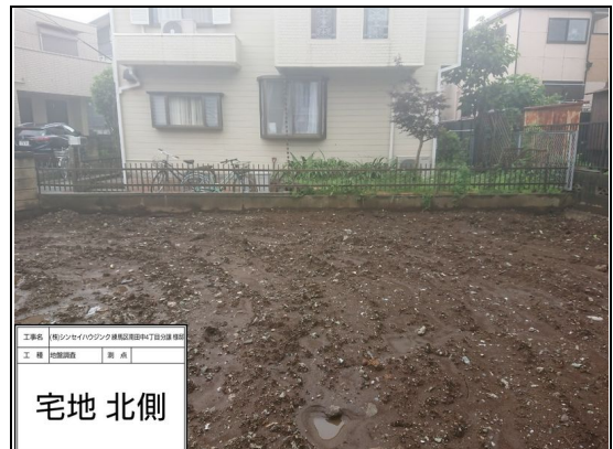
周辺状況 (宅地北側)
