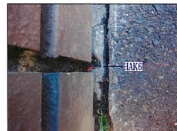
HAK6: コンクリート杭 (近景)
