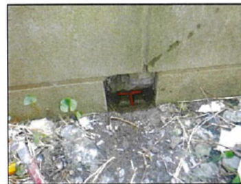
HAK19: コンクリート杭 (遠景)
