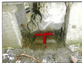
HAK19: コンクリート杭 (近景)
