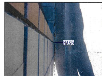
HAK6: コンクリート杭 (遠景)
