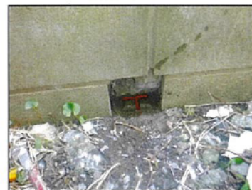
HAK19: コンクリート杭 (遠景)
