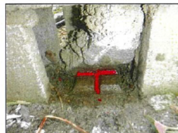
HAK19: コンクリート杭 (近景)
