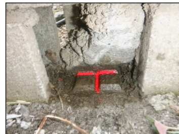
HAK19: コンクリート杭
