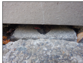
HAK3: コンクリート杭
