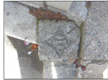
HAS7 : コンクリート杭
