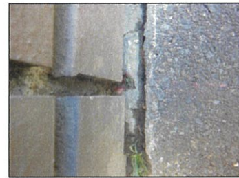
HAK6 : コンクリート杭
