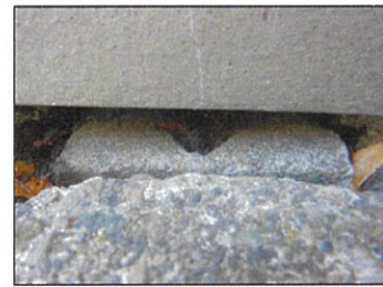
HAK3 : コンクリート杭
