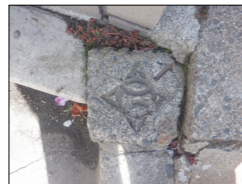
HAS7: コンクリート杭
