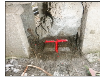
HAK19: コンクリート杭
