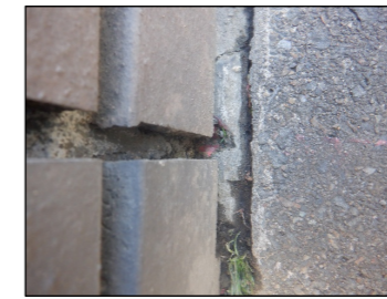
HAK6: コンクリート杭
