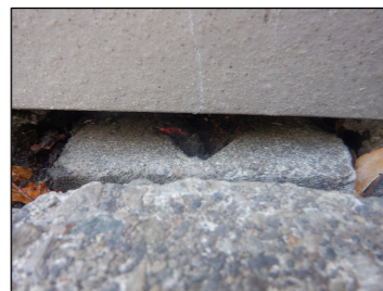
HAK3: コンクリート杭
