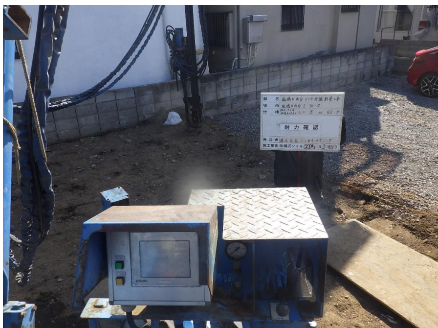
パイプ耐力測定状況
