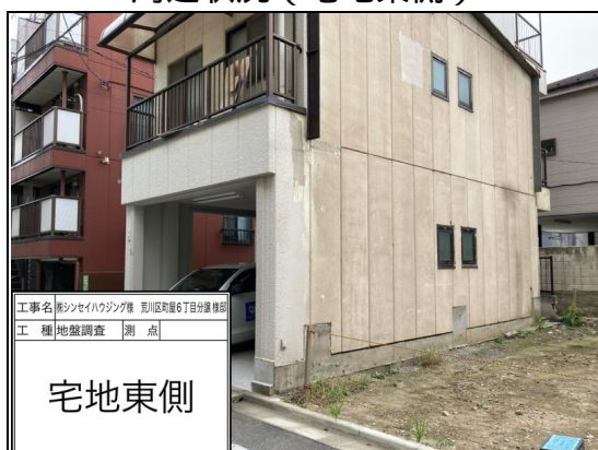
周辺状況 (宅地東側)
