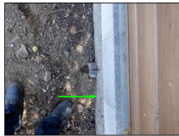
東ブロック塀基礎写真
