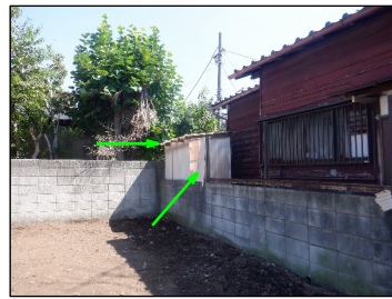
南トタン、トタン屋根写真
