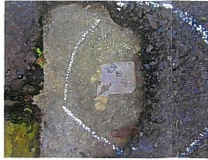
P. 1A 区金属プレート
