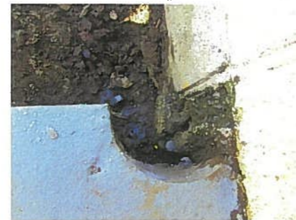
29 コンクリート杭
