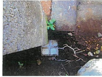
A8 コンクリート杭
